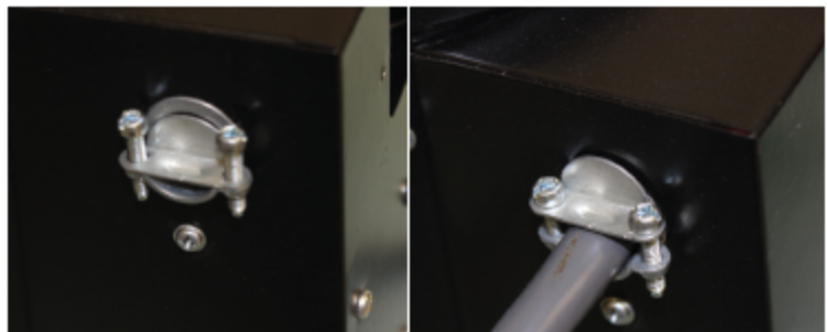
Figure 9: Instalación de la conexión del cable al calentador
