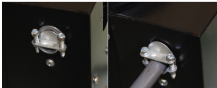
Figure 9: Installation du raccord de câble sur le radiateur
